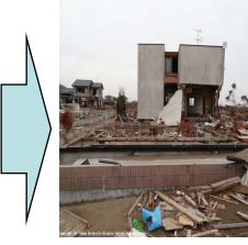
戸建住宅 布基礎 陸屋根 流出 床組 流木 万.礫 大規模破損
